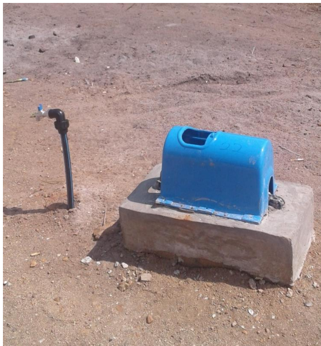
Gambar 3. Unit Sambungan Rumah yang dipasang
