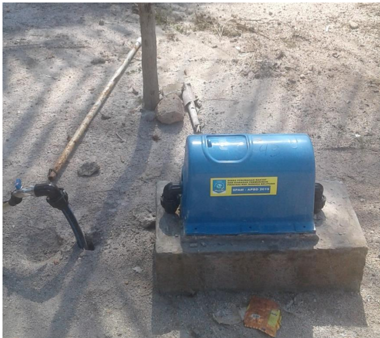
Gambar 1. Unit Sambungan Rumah yang dipasang
