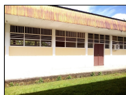
RUANG KELAS LISTRIK
