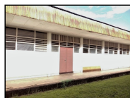
RUANG KELAS LISTRIK
