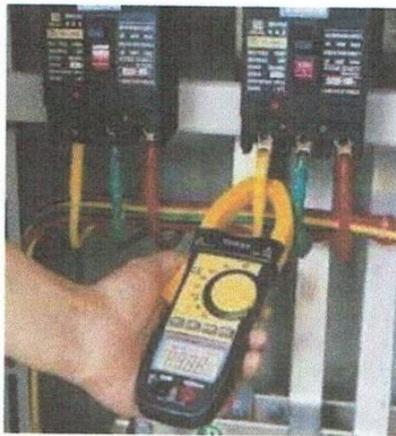
Gambar.E.8. Ilustrasi Pemeriksaan menggunakan Clamp Meter
