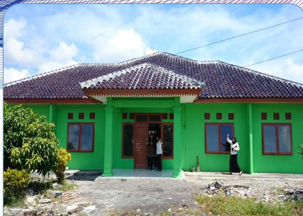
Pembangunan Fasilitas Informasi ATP 1 Unit
