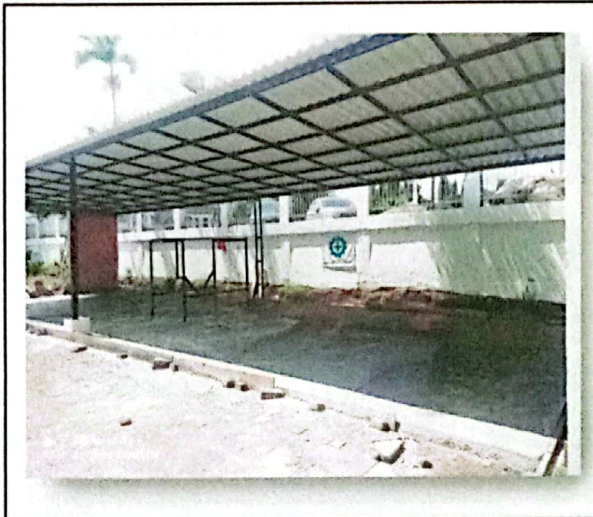
Hasil Pekerjaan Kanopi
