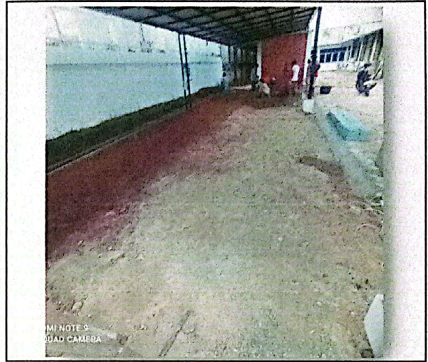
Persiapan Pekerjaan Lantai Kanopi
