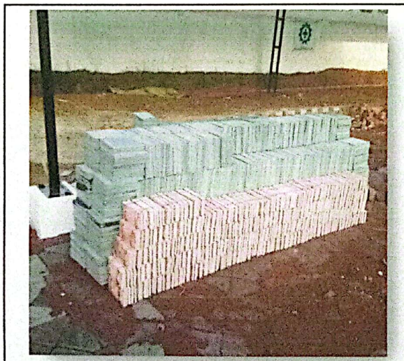
Persiapan Material Lantai Kanopi dan Batu Andesit Untuk Dinding Pembatas Parkir Motor
