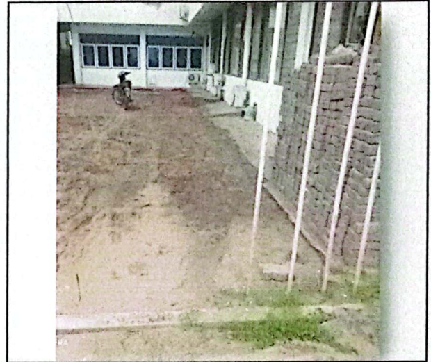
Pek. Pembongkaran Konblok Lama
