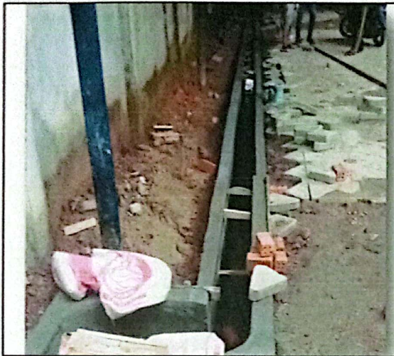
Pek. Pemasangan Acian Drainase
