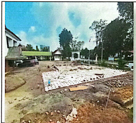
Pek. Pemasangan Konblok Uskup Area Depan
