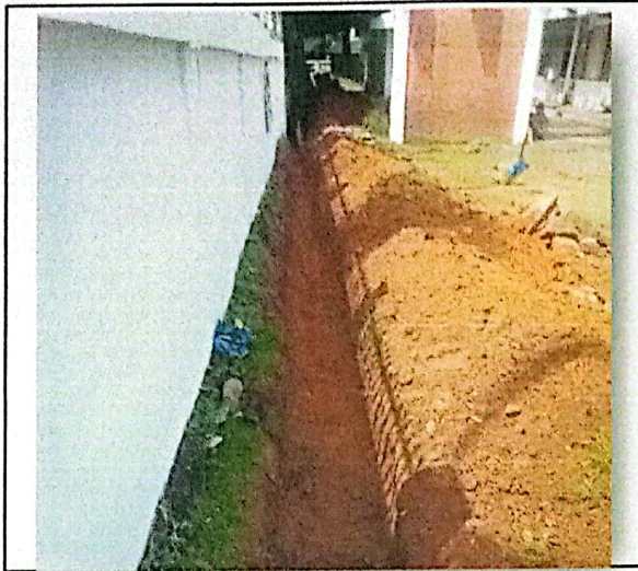
Pek. Penggalan Drainase Area Depan
