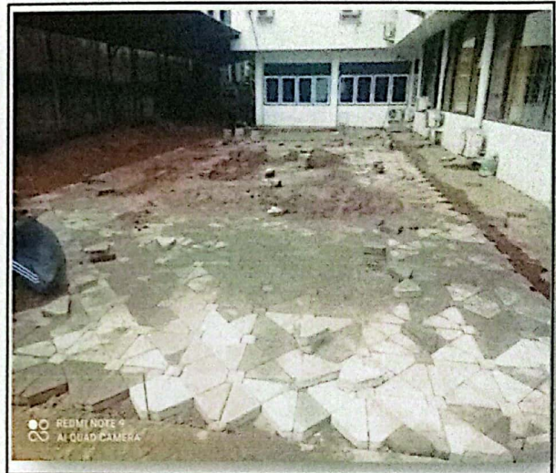
Pek. Pemasangan Konblok Uskup Area Parkir Motor
