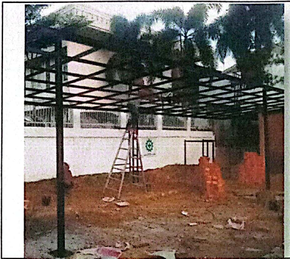
Pek. Pemasangan Rangka Atap Kanopi
