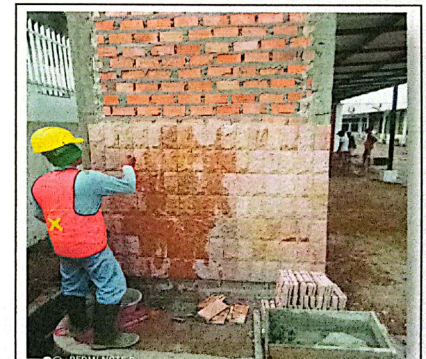
Pek. Pemasangan Batu Andesit Pada Pembatas Parkir Motor
