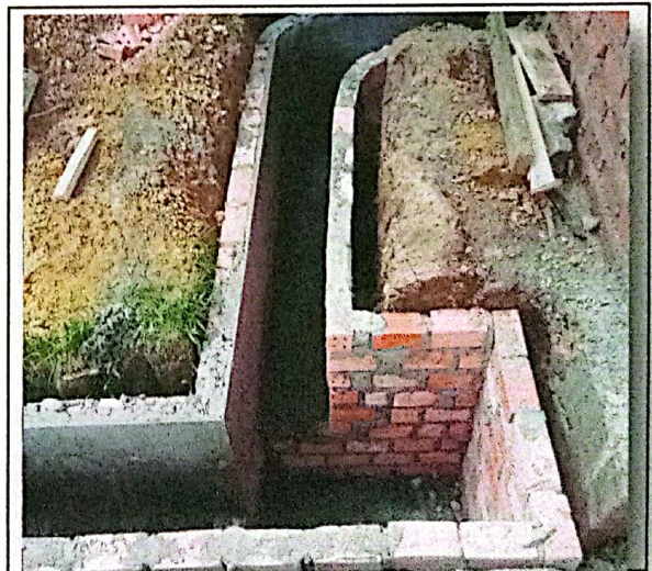
Pek. Pemasangan Bata Merah pada Bak Kontrol Drainase
