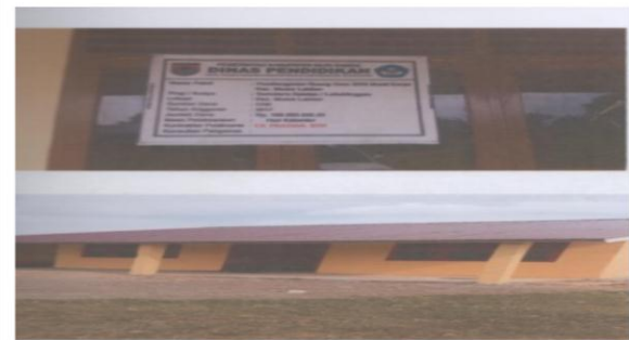
Pembangunan Ruang Guru SDN Sindang Laya Kec. Muara Lakitan Tahun 2017
