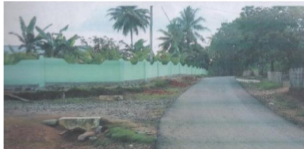
Pembangunan Pagar Sekolah Tahun 2017
