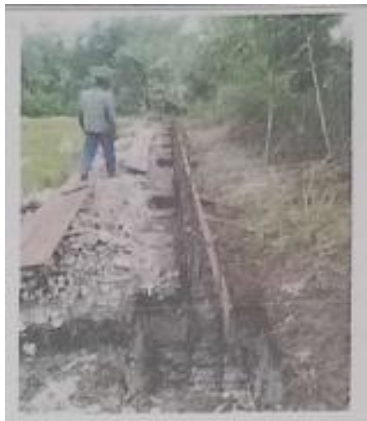
PEK. BEKISTING SLOOF
