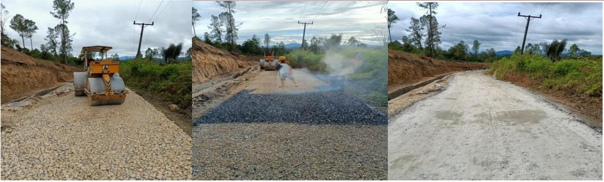
Gambar Pekerjaan Perkerasan dengan Telford
